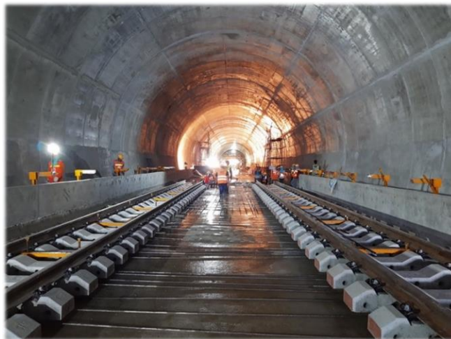
รูปที่ ๘ การก่อสร้างโครงการก่อสร้างทางรถไฟ สายเด่นชัย – เชียงราย – เชียงของ
